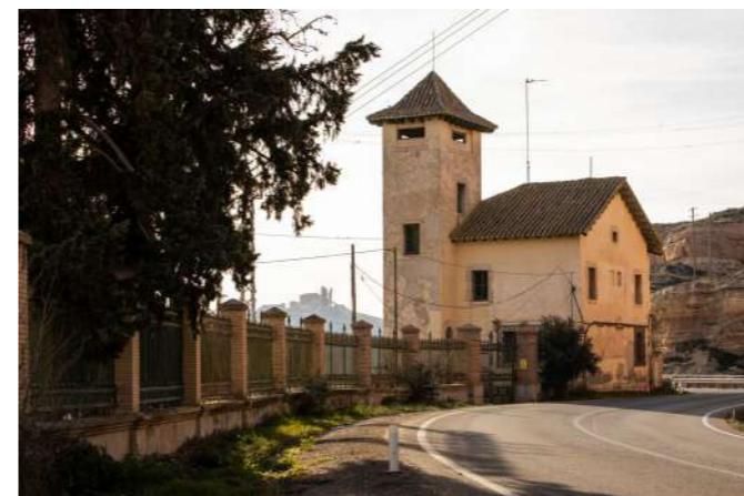
Fig. 38: Vista desde la carretera A-221 a su paso por la central hidroeléctrica Sástago II (6º perspectiva) - media tarde
