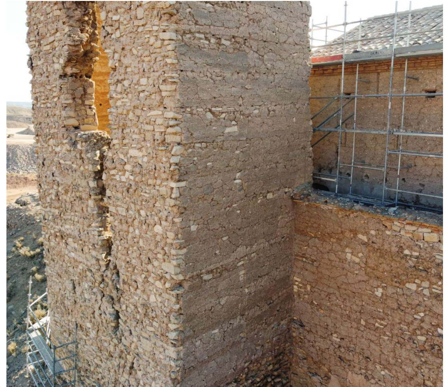
Fig. 51: Vista exterior de la torre principal
