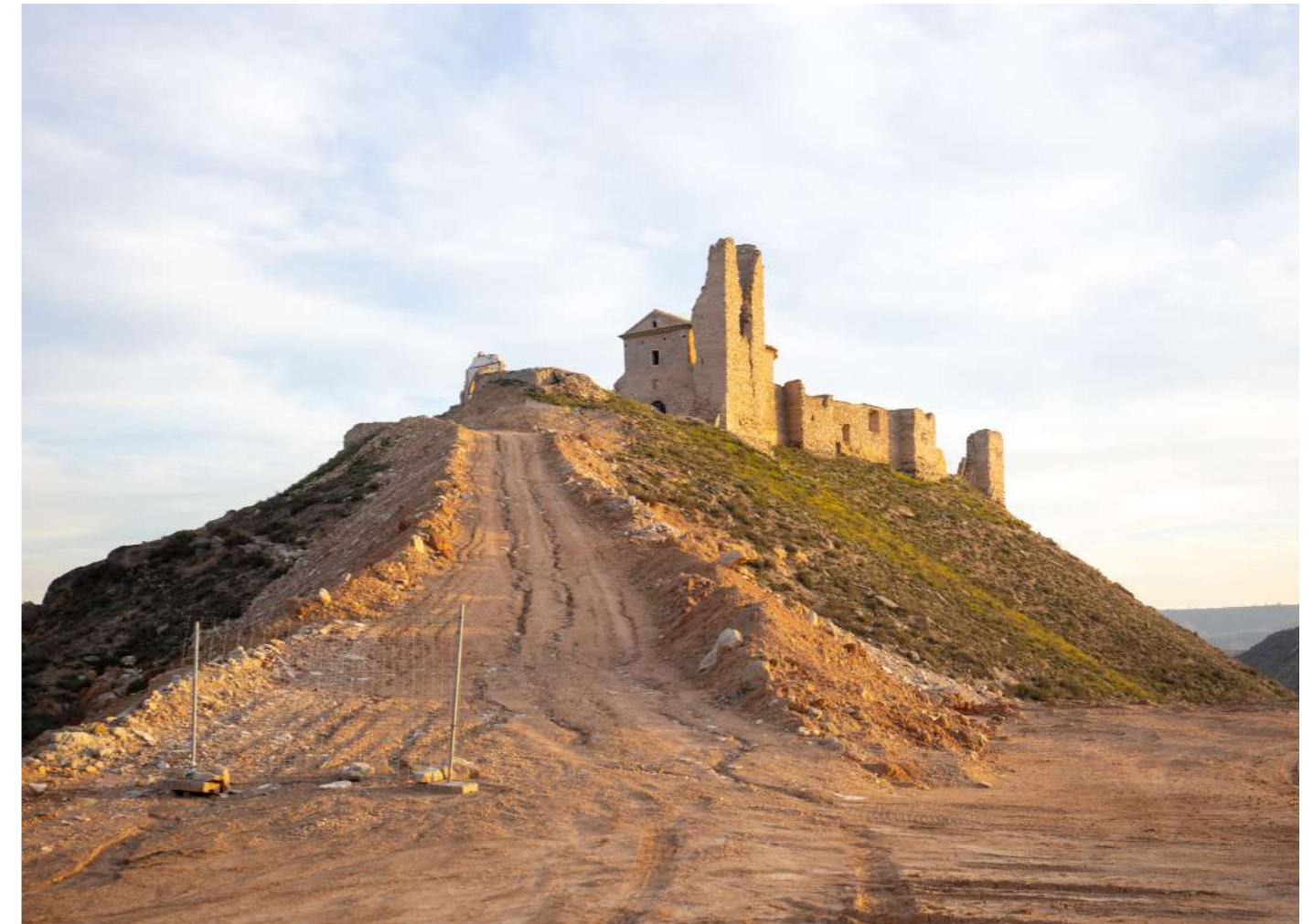
Fig. 33: El Castillo de la Palma desde el arranque de la nueva pendiente creada para facilitar los trabajos iniciales de conservación (1º perspectiva)
