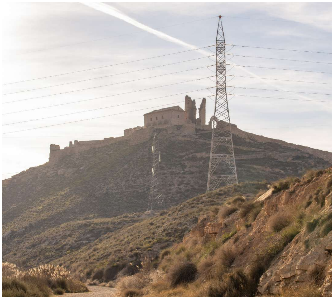
Fig. 34: Vista más cercana desde el camino que bordea el río Ebro en su margen derecha (2º perspectiva)
