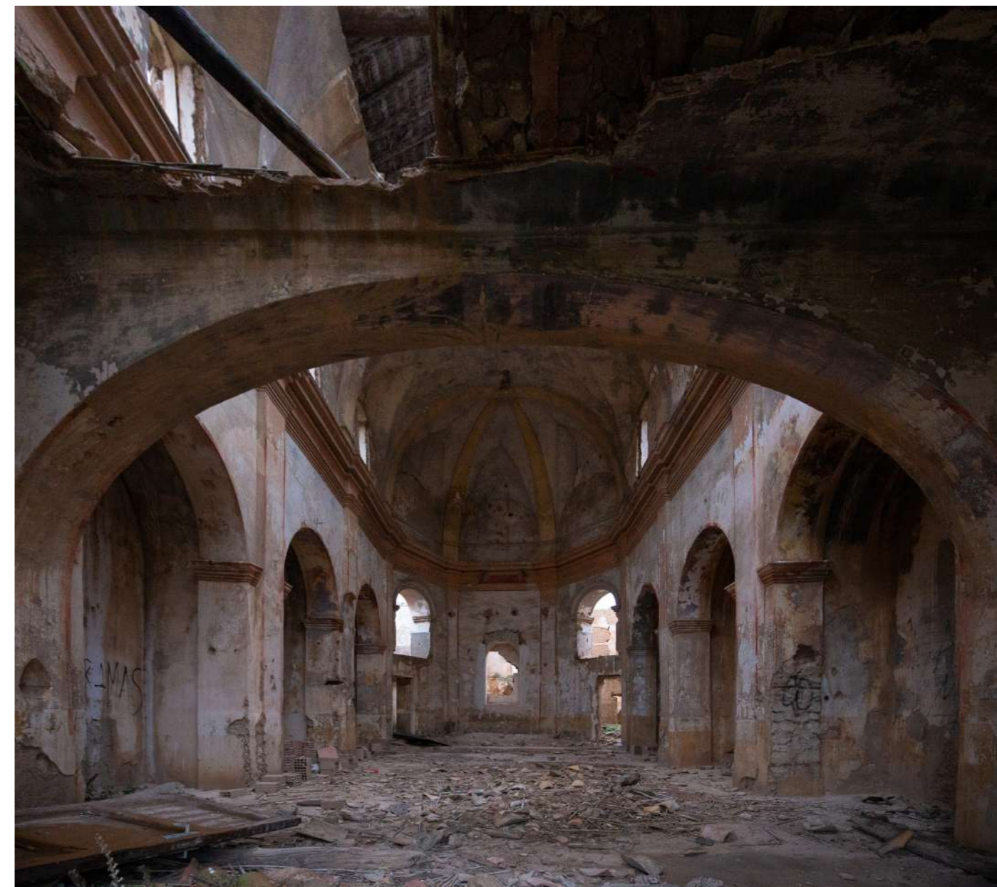
Fig. 56: Vista interior de la ermita del Pilar antes de los primeros trabajos de restauración
