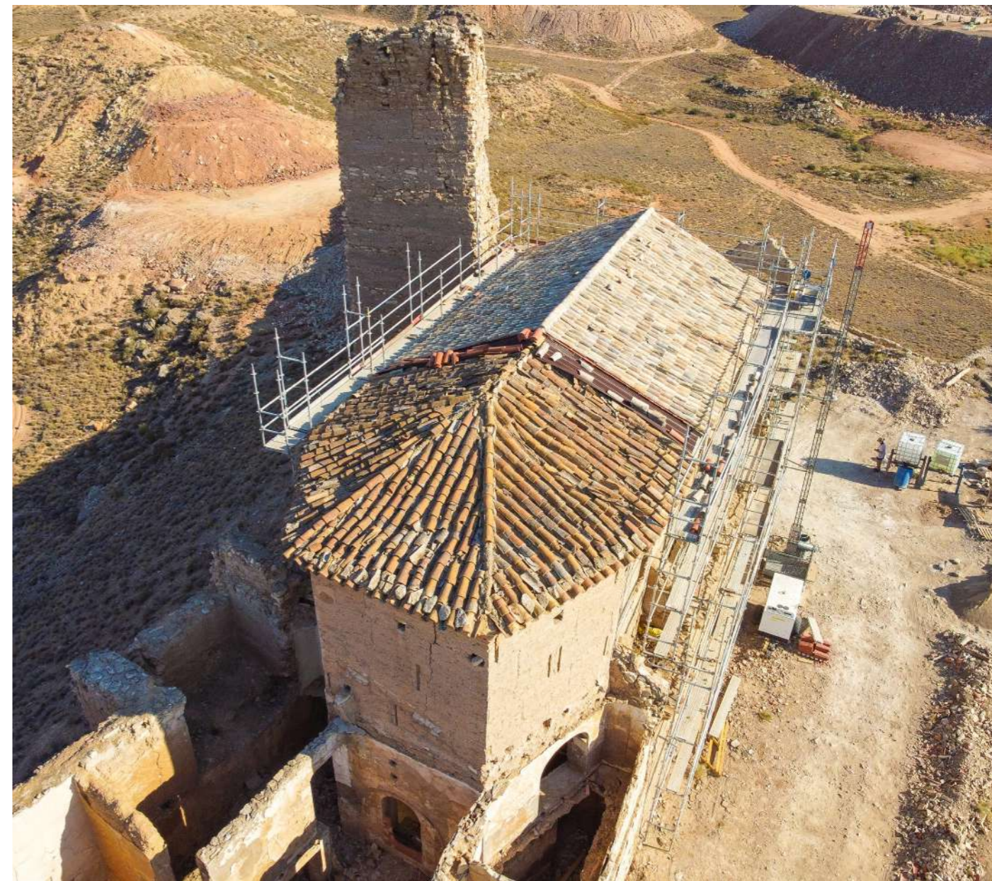
Fig. 73: Vista aérea de la cubierta de la ermita del Pilar en proceso de restauración
