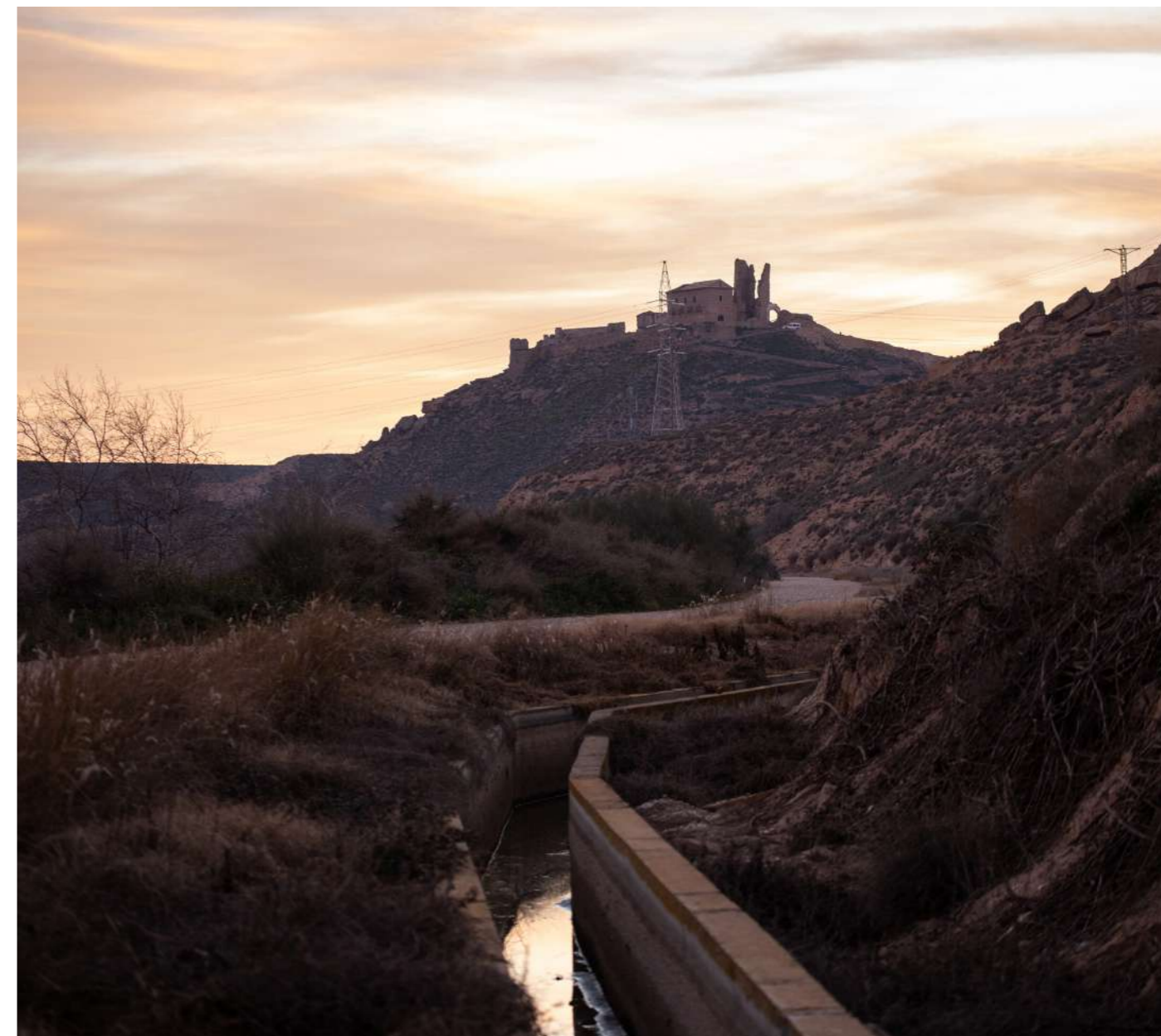
Fig. 35: Vista a media distancia desde el camino que bordea el río Ebro en su margen derecha (3º perspectiva)
