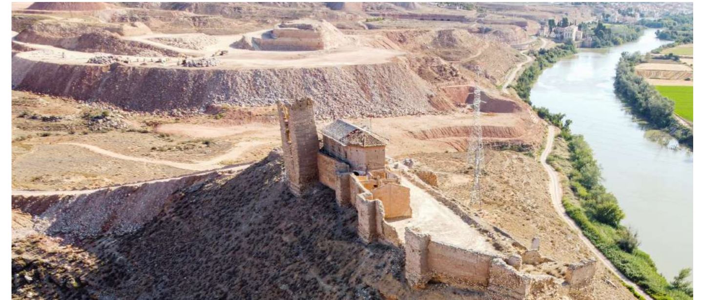
Fig. 29: Vista aérea del Castillo de la Palma junto a líneas eléctricas que atraviesan la zona y la mina a cielo abierto
